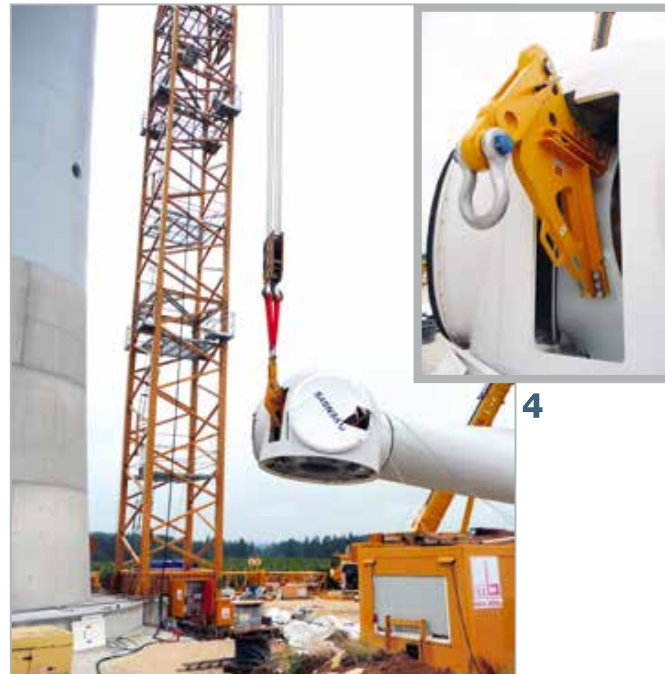
1-2 Gestellgreifer, innen greifend, mit Aufsetzautomatik.
